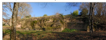
Panoramique du mur de soutènement (Béruges)
